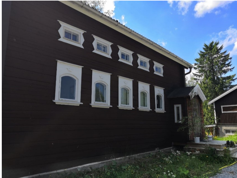
Kuva 5. Kuvassa päärakennuksen julkisivua.
