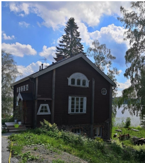
Kuva 8. Päärakennus idän puolelta kuvattuna.
